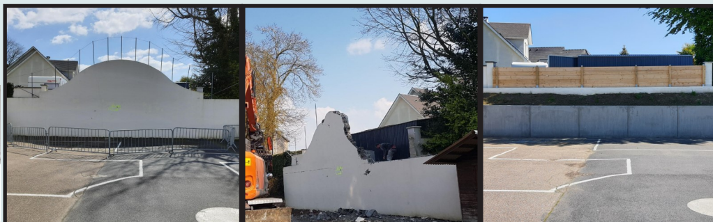
Travaux dans l'école : démolition du fronton (avant / pendant / après)
